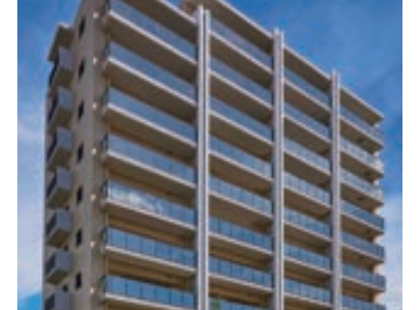
アルミ手すり
